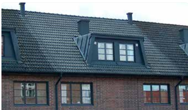
Tak av betongpannor med angrepp av alger. Två år efter behandling med Grön-Fri.
