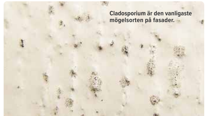
Täckmålad yta i närbild med påväxt av mögel.
