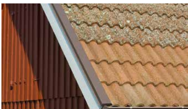
Tak av betongpannor med angrepp av lav. Två år efter behandling med Grön-Fri.
