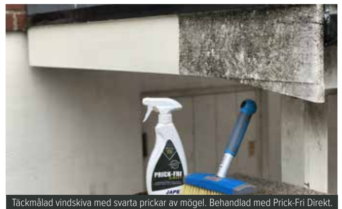
Täckmålad yta i närbild med påväxt av mögel.
