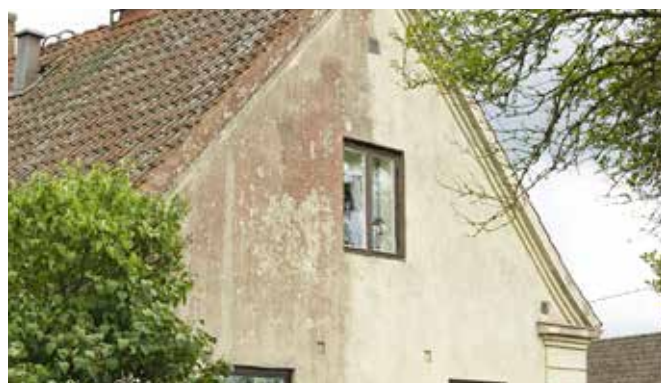
Putsad fasad med angrepp av rödalger. Fyra månader efter behandling med Grön-Fri.
